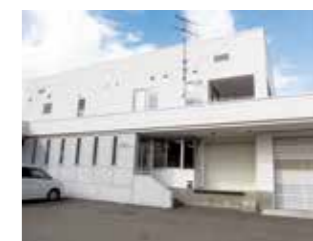
安代地区学校給食センター
