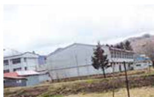
解体撤去予定の旧田山中体育館
