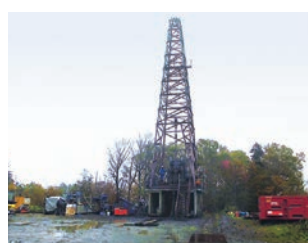
草の湯地熱発電所の調査現場
