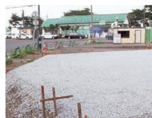
工事着手されている東大更駅前広場
