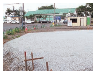
工事着手されている大更駅前広場
