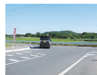
市道南北線と接続する砂田永持線
