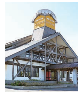
4月から安代老人憩の家の機能も持つ綿帽子温泉館
