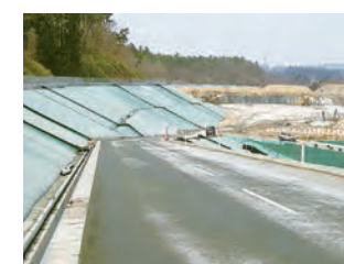
いわてグリーンセンターの埋立地
