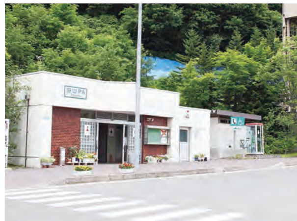
スマートICの設置で利便性の向上が期待される田山PA
