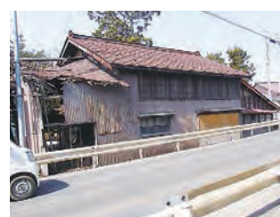
道路沿いの危険な空き家
