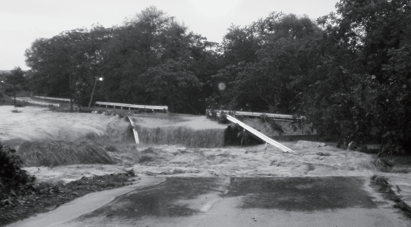
災害はいつどのような形で起こるか予想がつきません【松川の氾濫で破壊された市道山後線(西根地区・大更)、平成25年9月16日】
