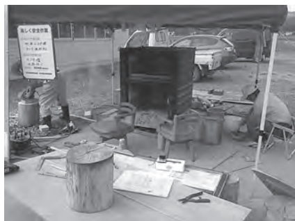
天井アーチ作り
