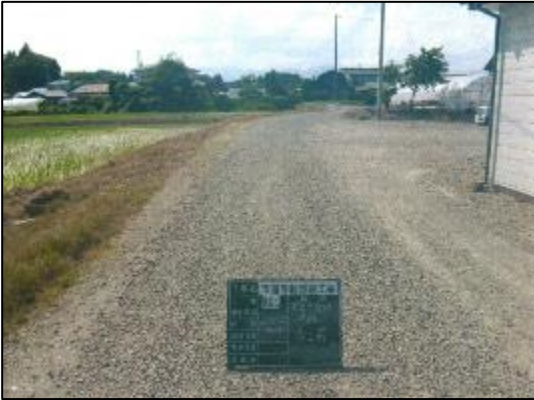
【軽舗装工事】R7平笠地区
