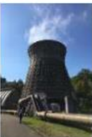
▲松川地熱発電所
