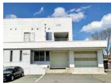
安代地区学校給食センター
