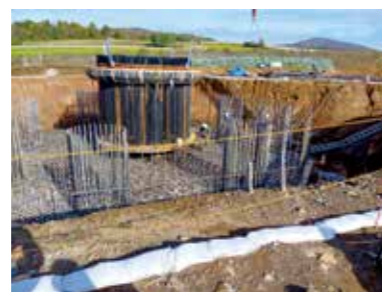
稲庭風力鉄塔基礎工事現場
