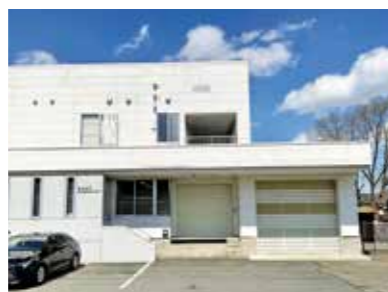
安代地区学校給食センター
