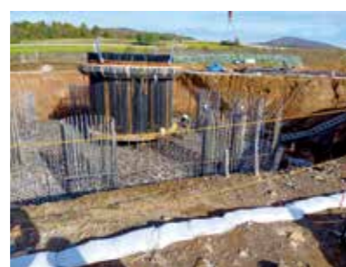
稲庭風力鉄塔基礎工事現場
