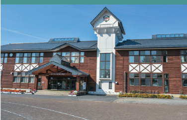
9年4月に開校する松尾地区統合小学校の校舎となる現松野小学校
