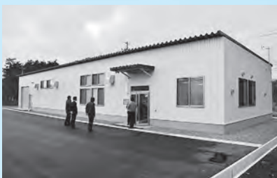
有限会社生出精密の新工場が落成し、関係者に披露されました(12月6日、大更地内)
