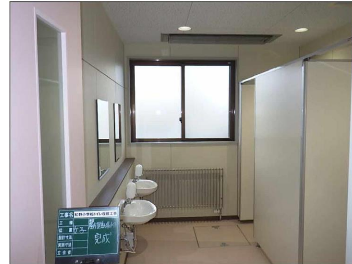
体育館トイレ改修
