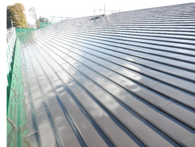
屋根塗装完了
