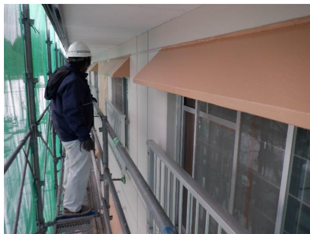
外壁塗装完了確認
