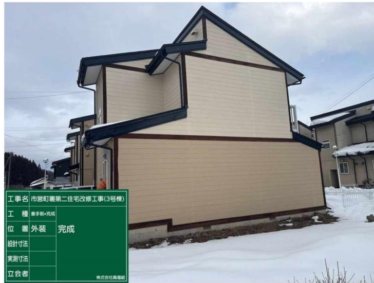
屋根、外壁塗装
