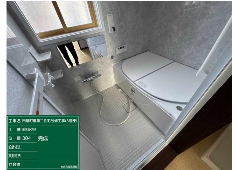
内部改修 三点給湯 (台所シンク更新及びユニットバス化)
