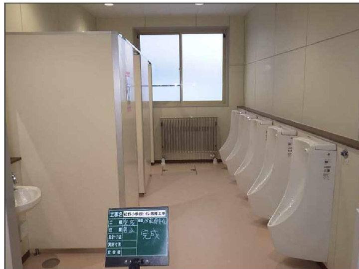
1 階東側トイレ改修
