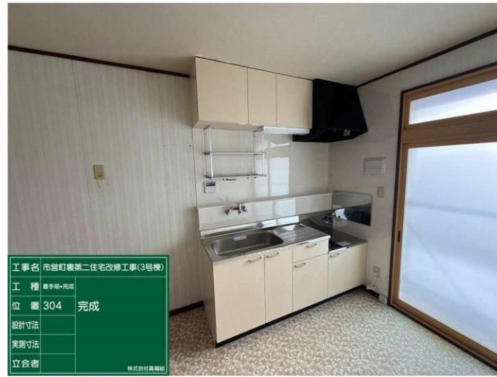
内部改修 三点給湯 (台所シンク更新及びユニットバス化)
