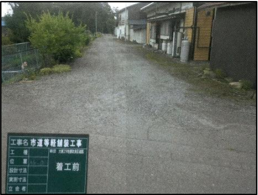
【軽舗装工事】R6大更地区
