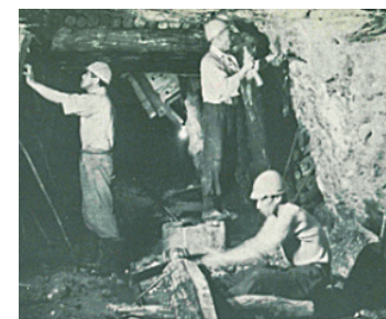
軟弱な箇所を補強する支柱手
