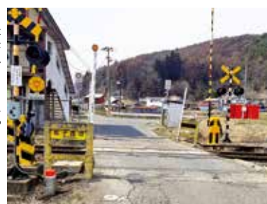
早期の拡幅工事が必要な松子踏切
