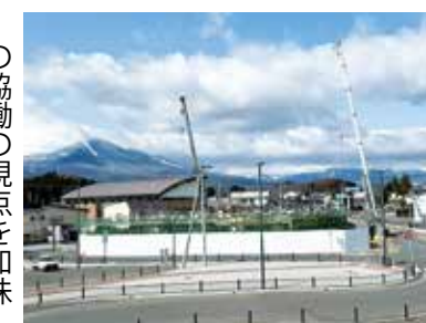
建設が進む大更駅前顔づくり施設
