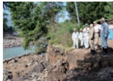
松川の濁流で破壊された松川橋上流の護岸
