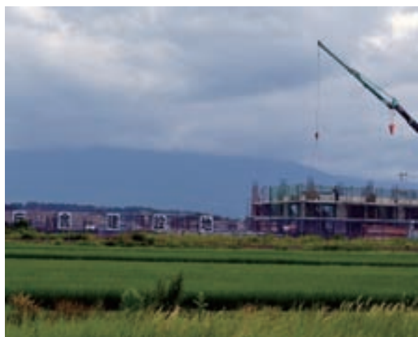
市の防災拠点としても、来年の完成が待たれる新庁舎の建設現場
