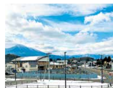
工事が進む大更駅前顔づくり施設
