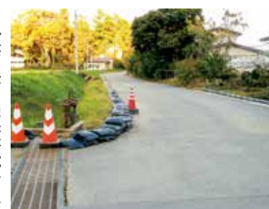
水路越水による土のう設置状況
