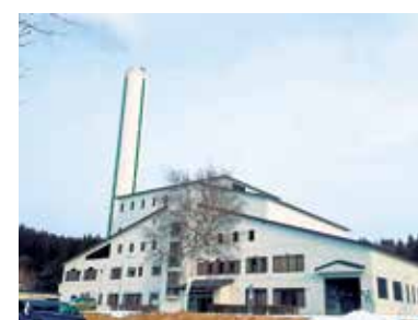
広域化で取り壊し予定の焼却施設
