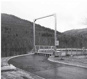
整備された緊急入退出路
