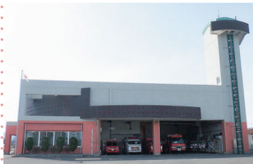
八幡平消防署(市防災センター)を改修
