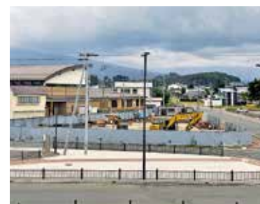
工事が進む大更駅前顔づくり施設
