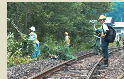
田山・館市両振興協議会が中心となり、JR花輪線沿線の支障木を伐採(9月18日、支障木伐採共創事業)
