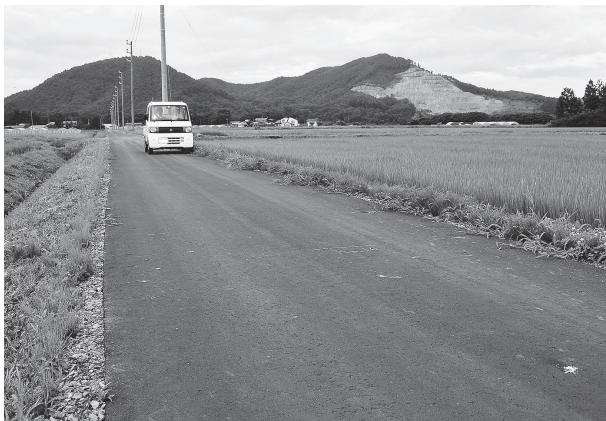
交付金を利用して舗装整備された北村地区の農道
