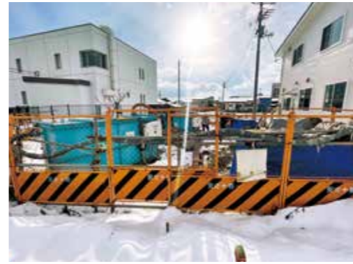
除染作業が続く元クリーニング工場跡地
