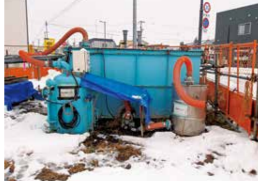
土壌改良業務の現場
