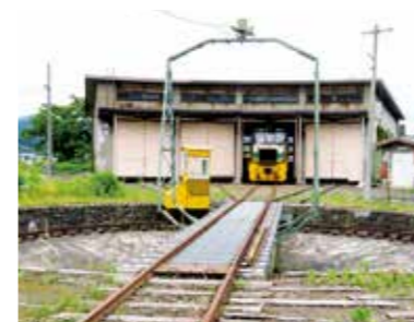
荒屋新町駅扇形機関庫と転車台
