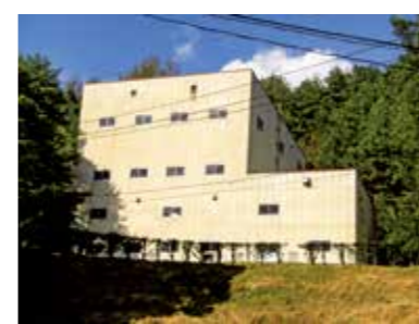
解体が急がれる焼却場などの建物
