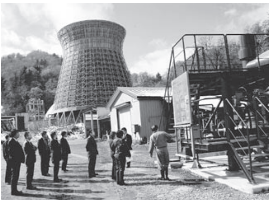
昭和41年に運転が開始された松川地熱発電所。大震災後地熱などの再生可能エネルギーが注目されています
