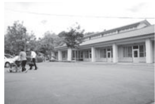
現建物の東側(写真)と南側に接し30床増床される特別養護老人ホーム「むらさき苑」。オール電化で今年度中に完成の予定です
