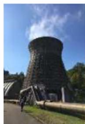
▲松川地熱発電所
