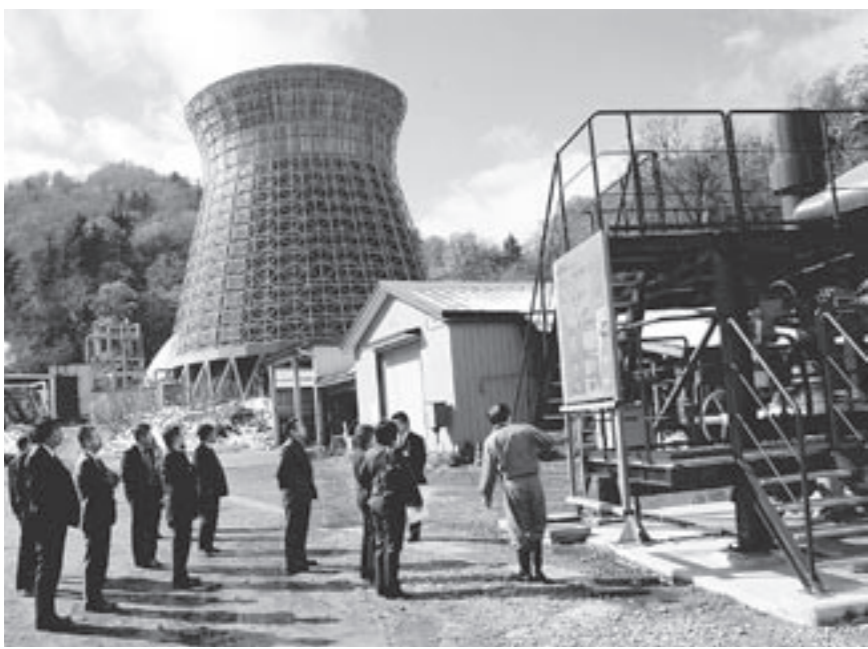
昭和41年に運転が開始された松川地熱発電所。大震災後地熱などの再生可能エネルギーが注目されています
