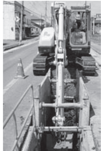
公共下水道工事により汚水管の布設が進んでいます（平館地区内）
