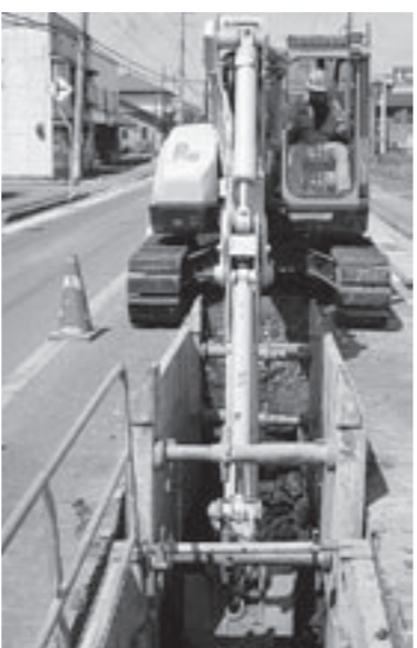
公共下水道工事により汚水管の布設が進んでいます（平館地区内）
