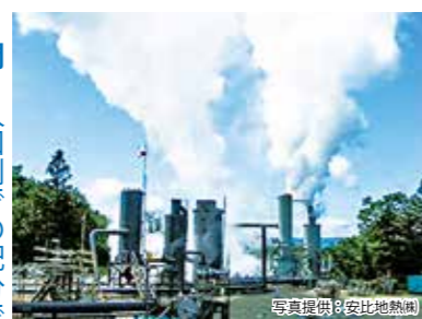
建設工事が進む安比地熱発電所 (噴気試験の様子)
