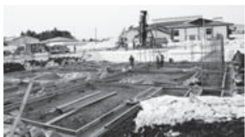
松尾柔剣道場北側に建設中のコミュニティセンター
