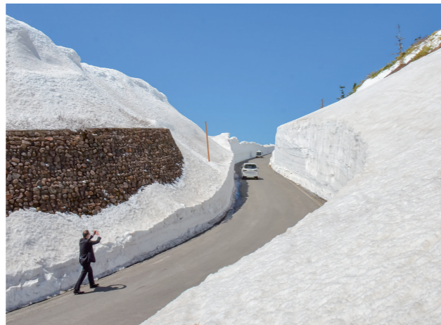
3月18日から除雪を開始。雪壁の高さは最大9.5mです
