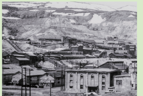
斜面にベルトコンベヤーが連なる選鉱施設
