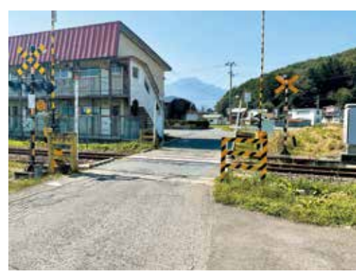
一刻も早い踏切の拡張工事を望む(松子踏切)
