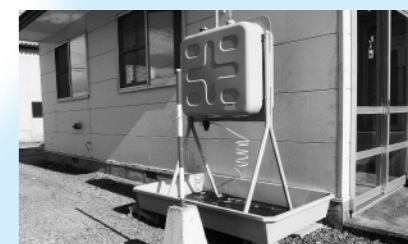
除雪機械の衝突防止に目印を設けましょう
