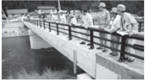
市道岩屋岩木線・岩木橋
