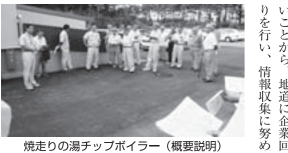
焼走りの湯チップボイラー (概要説明)
