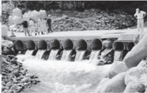
おひあわせ 折合橋緊急補修工事現場
