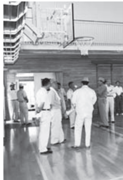
田山小学校屋内運動場
