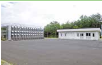
新小屋の沢配水池
