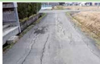
冬季の凍結による陥没ひび割れ
