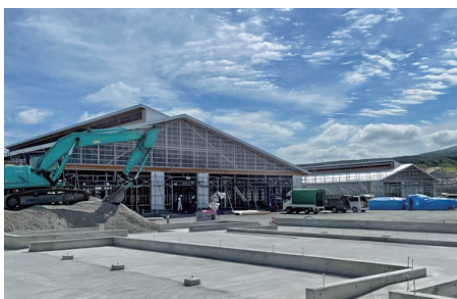
上坊牧野付近に建設中の牛の繁殖育成センターは、9月開所を予定(3年9月28日)
