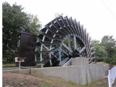
水の力を利用した小水力発電(明治百年記念公園) 発電出力 9.9kW
