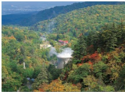
地熱を活用して発電を行う松川地熱発電所 発電出力 23,500kW
