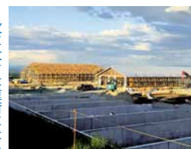
上坊牧野に建設中の繁殖育成センター
