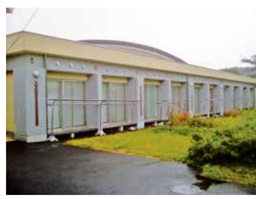
安代ふれあいセンターに隣接する生活支援ハウス
