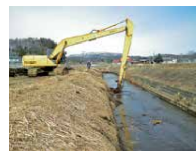
河川の土砂撤去
