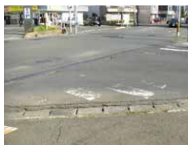
白線が消えている横断歩道
