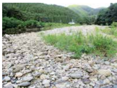
堆石で盛り上がった米代川夢大橋下
