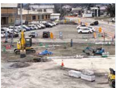
大更駅前周辺整備事業の現状
